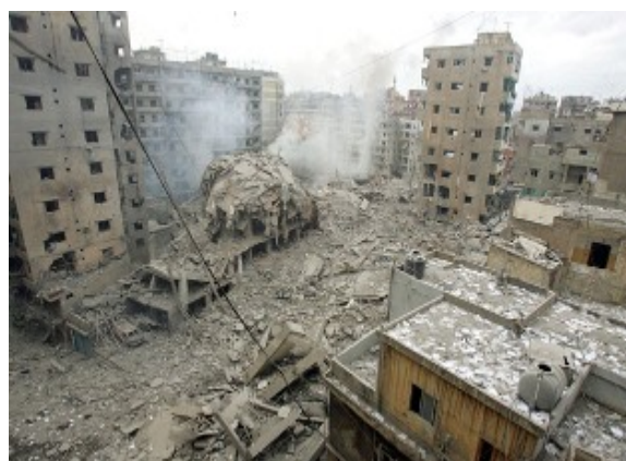
Разрушения, вызванные войной Израиля в Газе, 2014 г.
